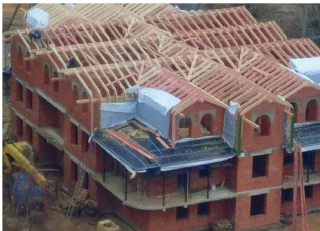
Монтаж стропильной системы кровли.
