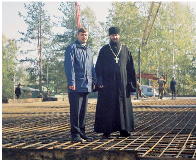
Начало бетонирования Соборного фундамента. Слева - Валерий Кравцов
