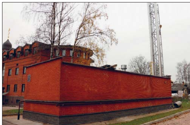
Приходская газовая котельная
