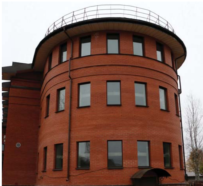
Пристройка для размещения специализированного лифта в детском корпусе
