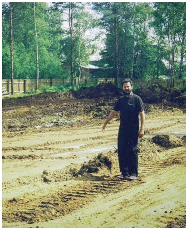
В «зыбком» котловане будущего Собора
