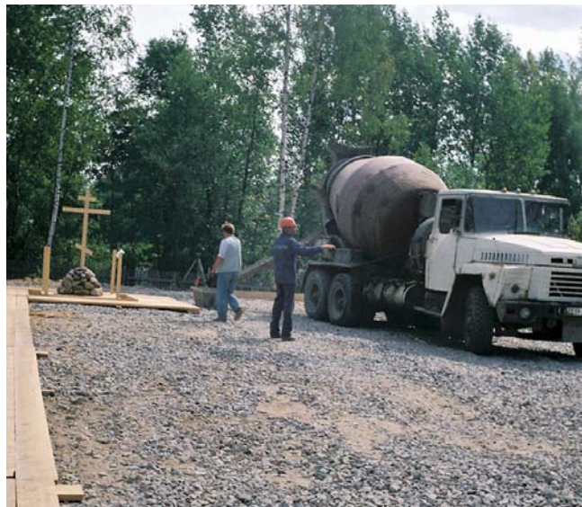
«Одинокий» миксер бетона под стяжку
