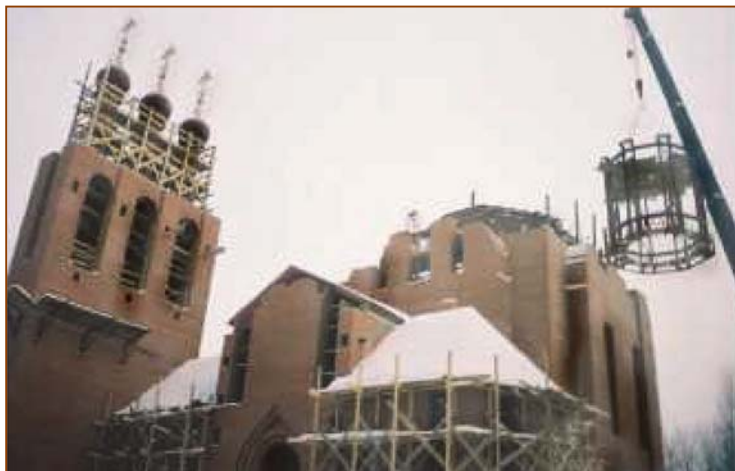
Подъем центральной металлической ротонды
