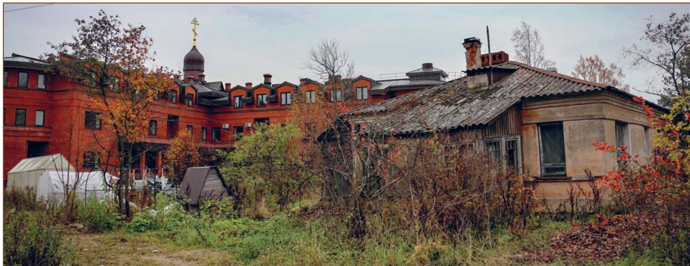
Развалины домов у здания будущего Детского Хосписа
