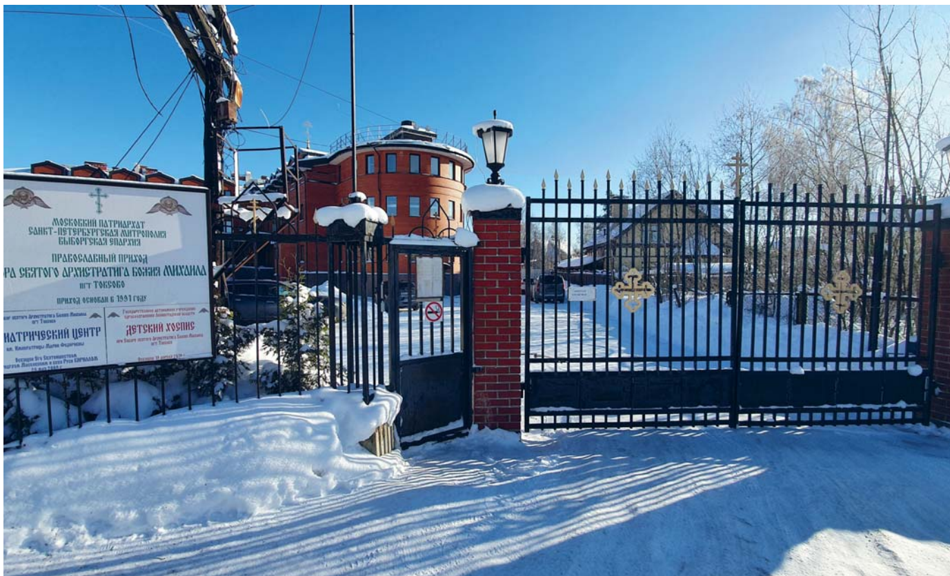
Въезд с улицы Швейников к зданию Хосписа.
