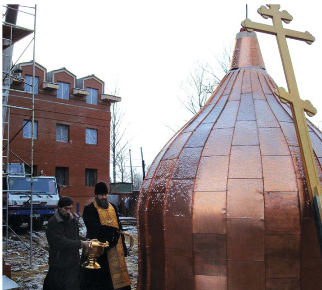
Освящение медного Купола и Креста перед подъемом на детский приходской корпус.
