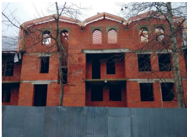
Оконные проемы готовы и ждут остекления.
