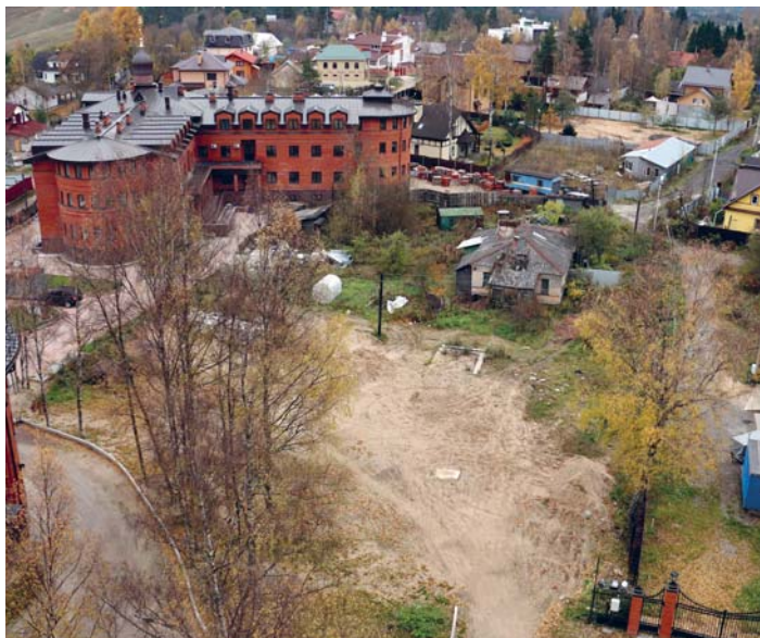
Площадка после сноса одного из ветхих домов.
