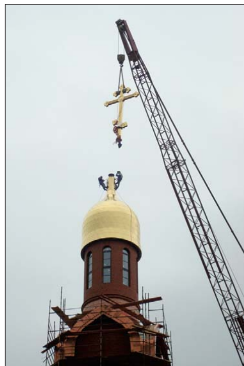
Установка Креста на высоту более 60 м
